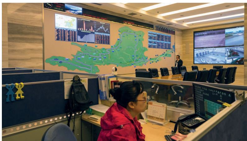
Les ingénieurs de la Commission de Conservation du Fleuve Jaune contrôlent depuis cette salle de nombreux indicateurs : débit, niveau des réservoirs, qualité de l'eau... sur les plus de 5 000 km de linéaire du fleuve. Ils supervisent les allocations de ressource en eau, en manœuvrant à distance les vannes des retenues.
