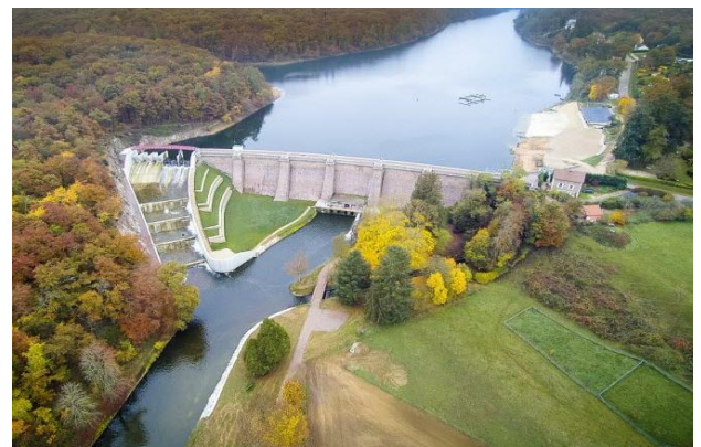
Barrage de Pont-et-Massène @VNF
