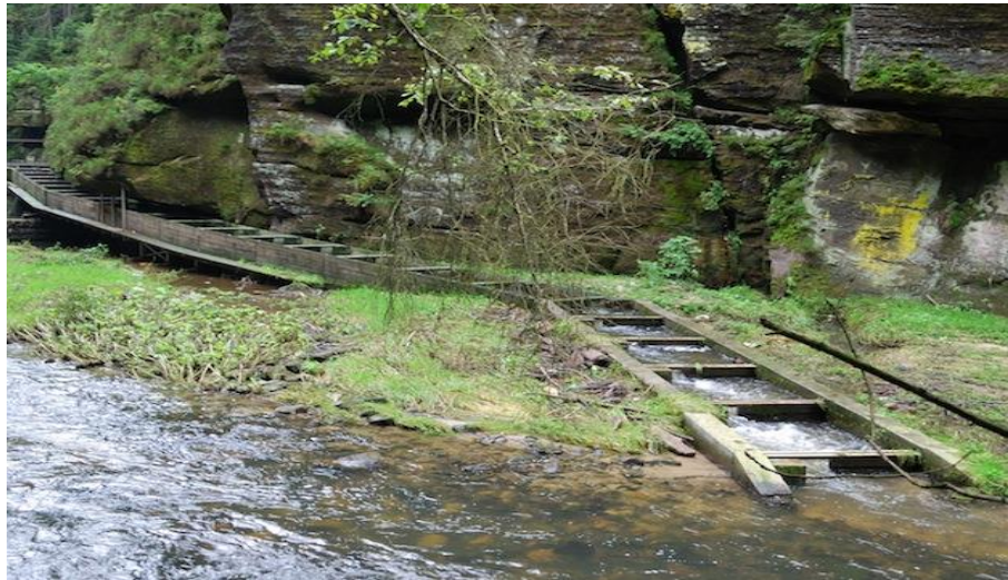
Sur le bassin Seine-Normandie, dans la partie occidentale de Côte-d'Or, mise en place d'ouvrages permettant la libre circulation des poissons et d'un transit sédimentaire / Source : Hydraulixois
