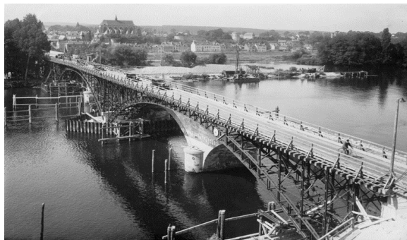
Photographie datant de 1935 qui montre les travaux effectués pour l'élargissement des arches du Pont-de-l'Arche afin d'améliorer la navigation sur la Seine
