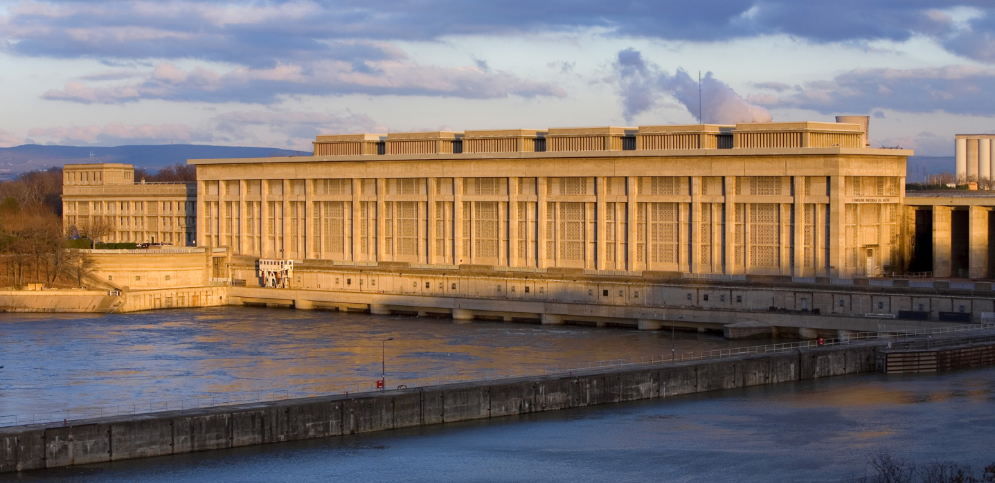
Centrale de Bollène sur le Rhône (Vaucluse, France)
